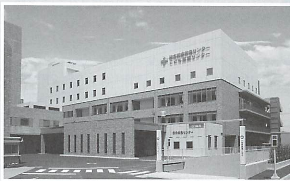
総合救命救急センター・こども医療センターの外観
